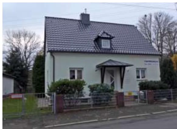
Wohnhaus in Unterwellenborn/ Könitz © Handwerkskammer für Ostthüringen
